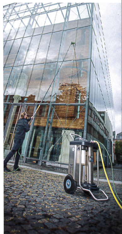
Die Verwendung von Reinwasser sorgt für streifenfreie Reinigung unter anderem von Glasfassaden.
