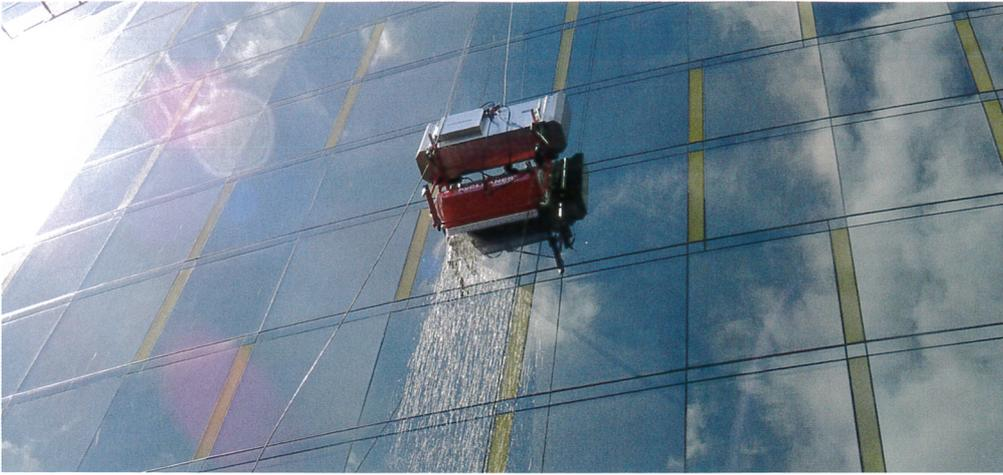
Da der Hotel- und Unterhaltungskomplex bereits über ein Schienen- und Gondelsystem zur Fassadenreinigung- und Instandhaltung verfügt, bot es sich an, den Hycleaner Red Evo II für die nächste Reinigung zu nutzen. (Foto: TG Hylift)
