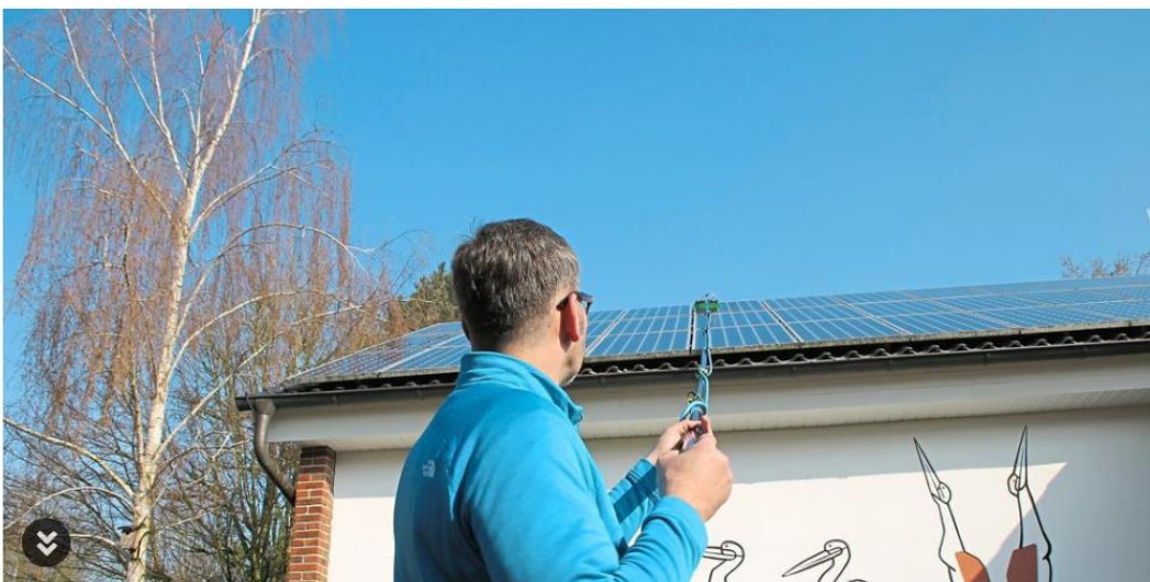
Die 13,5 Meter langen Karbonstangen ermöglichen die Reinigung der Module vom Boden aus. Foto: Stadtwerke/Stefan Busch
