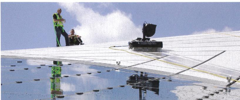
Durch die halbautomatische Reinigung mit dem kleinen Roboter können Reinigungskräfte entlastet werden.
