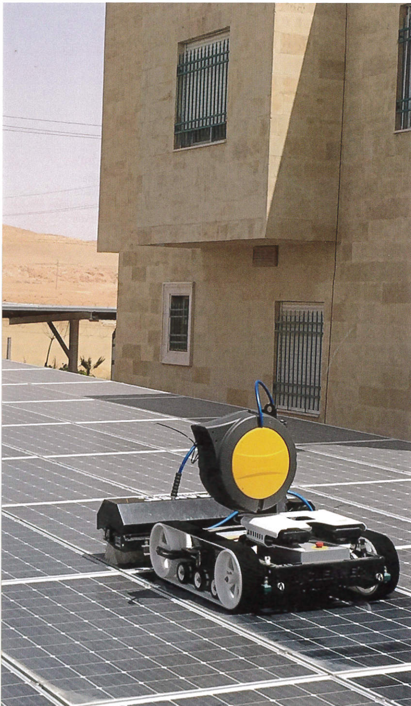
Die Solaranlage auf einer Parkplatzüberdachung wird ohne Wassereinsatz abgefeigt.
