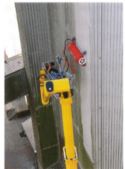
Der hyCleaner red reinigt halbautomatisch Fassaden aller Art.
