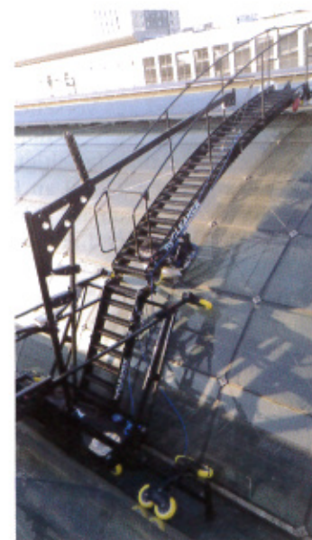
Zweimal jährlich soll das komplette Dach des Bahnhofs Berlin-Spandau nun mit dem halbautomatischen Hycleaner-System gereinigt werden. (Foto: TG Hylift GmbH)
