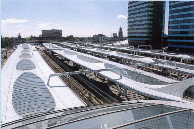
Allein die Fläche der vier 210 Meter langen Bahnsteigüberdachungen beträgt 8.700 Quadratmeter.
